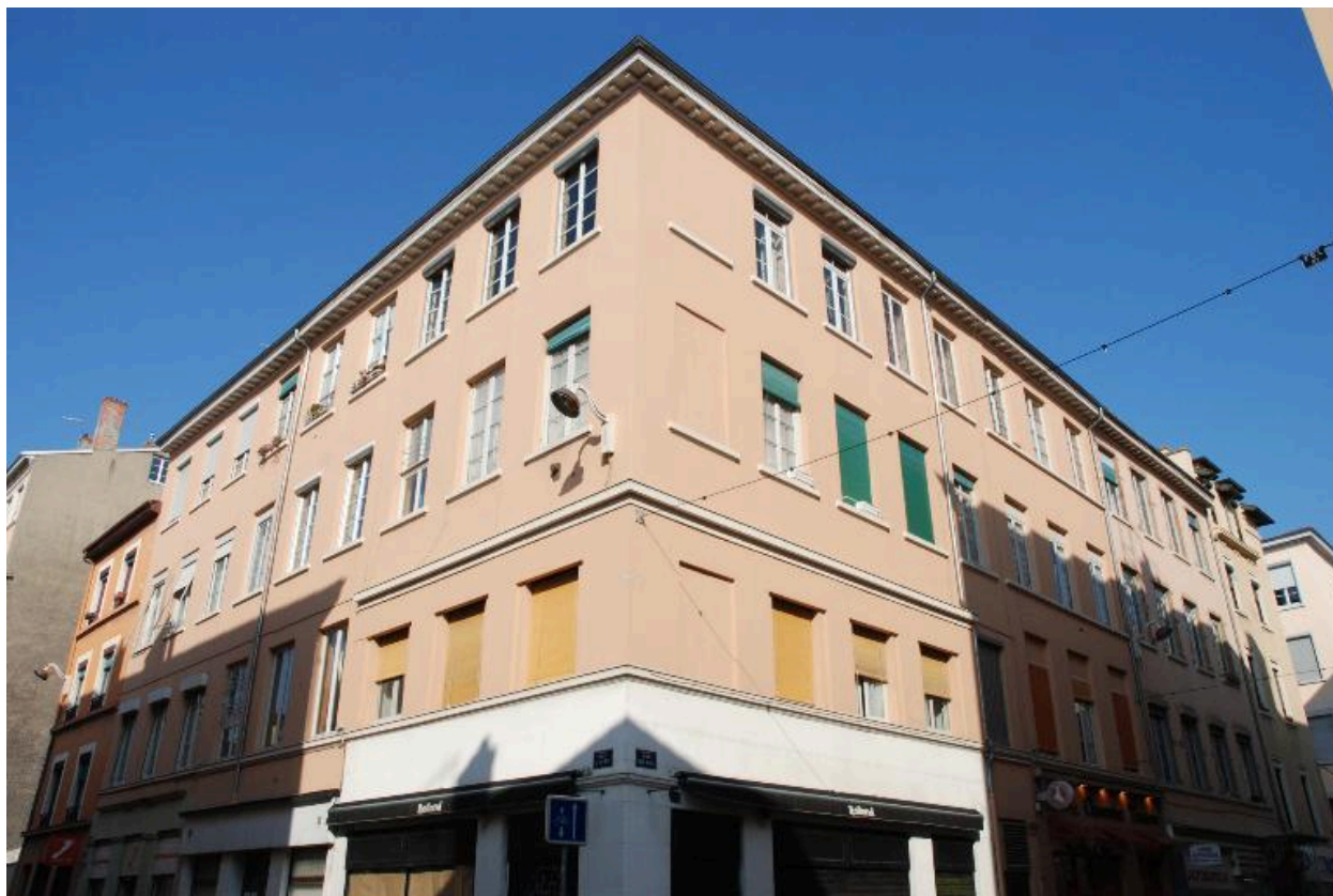
Vue d'ensemble sud est
