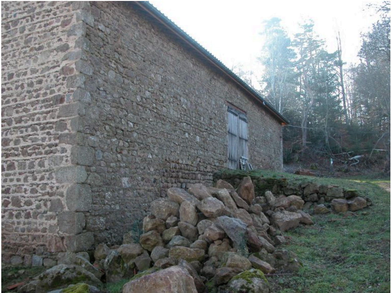
Grange-étable de la ferme, vue partielle de la façade arrière de la grange avec présence du montoir.
