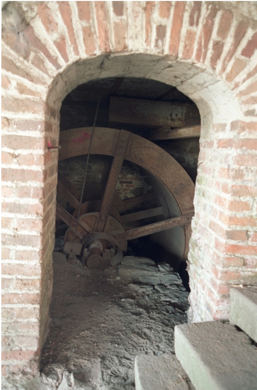
Détail de l'ouverture d'accès à la roue hydraulique métallique, côté nord du moulin.
