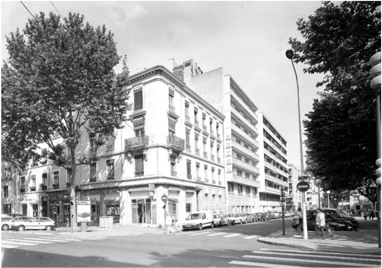
Vue générale depuis le sud-ouest
