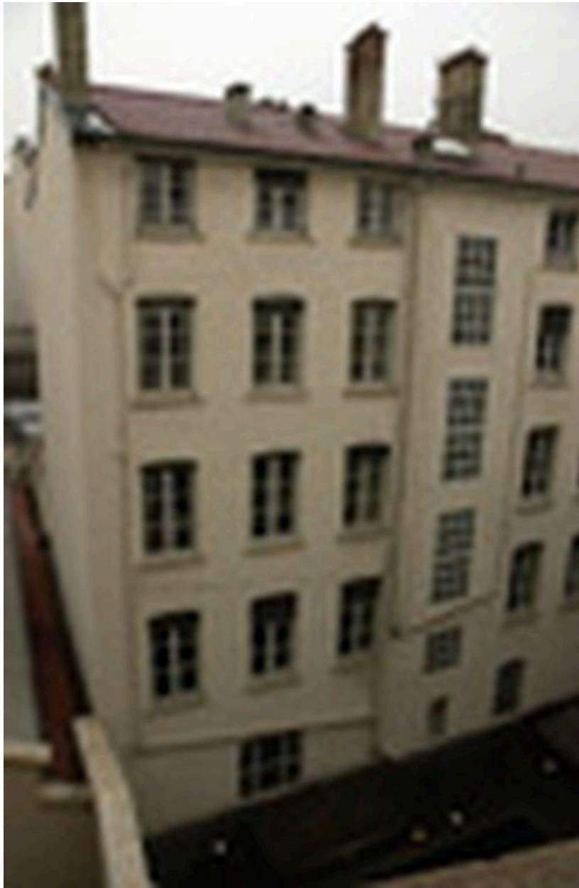
Vue du 3 rue de Savoie de l'escalier du corps de bâtiment principal
