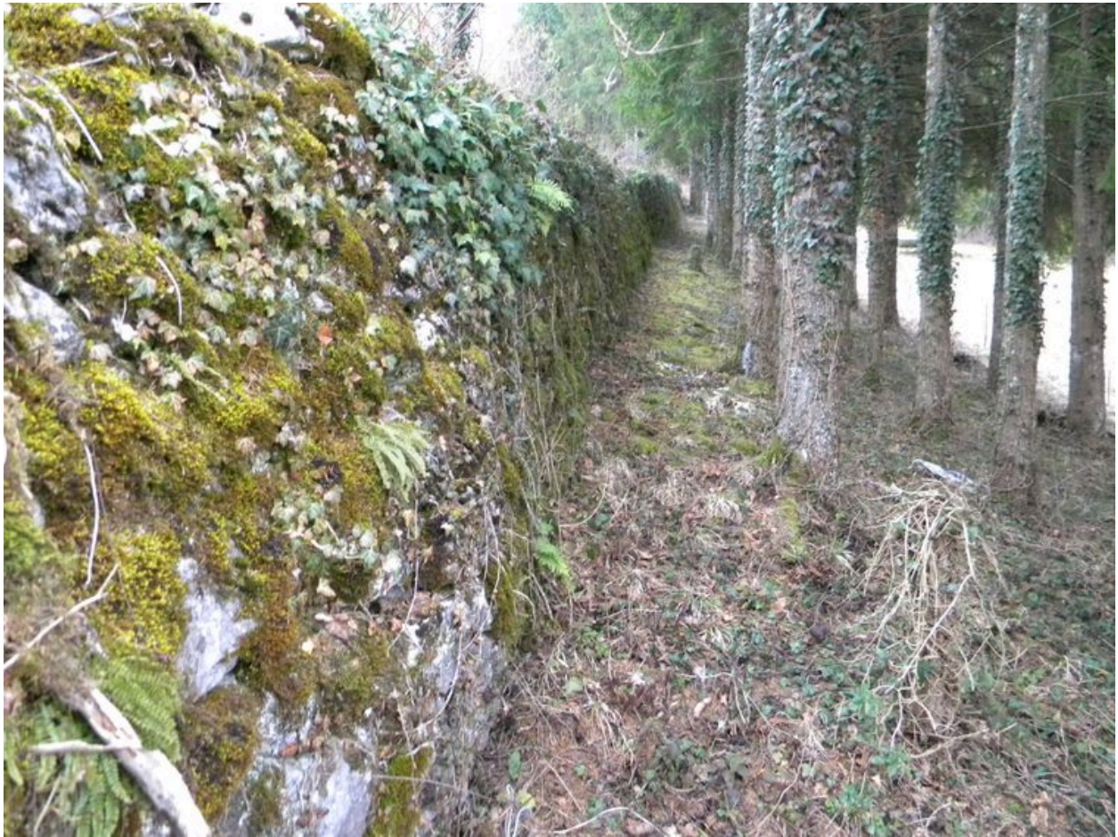
Mur de soubassement d'un chemin (2008 A9 1407).
