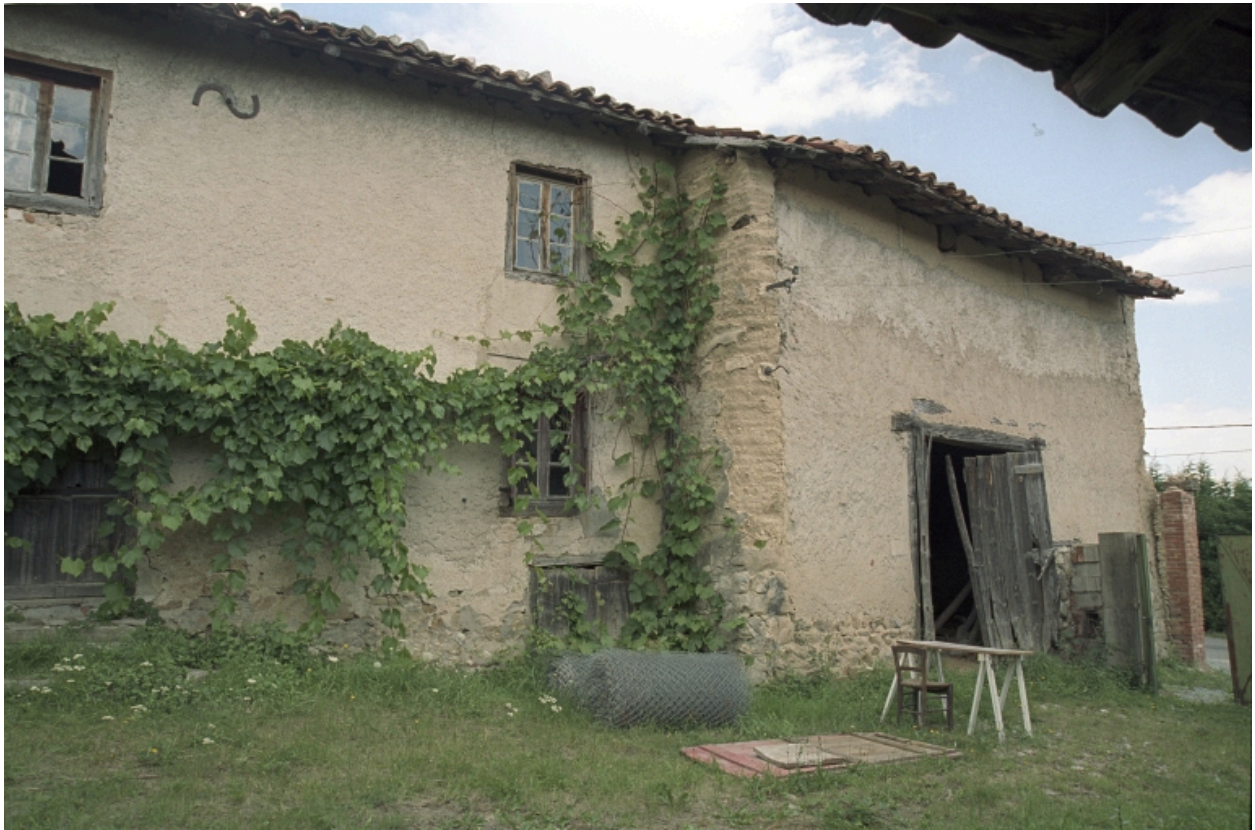
Marcoux, Rocheat (1986 ZD 226), type A2. Façade antérieure du logis et cuvage.
