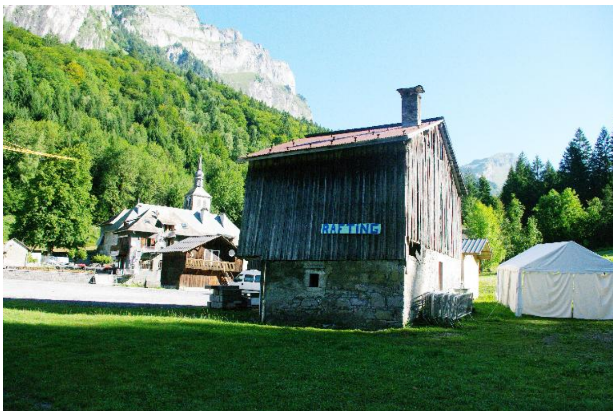
Bâtiment agricole se trouvant sur l'ancien tènement des usines de Sixt
