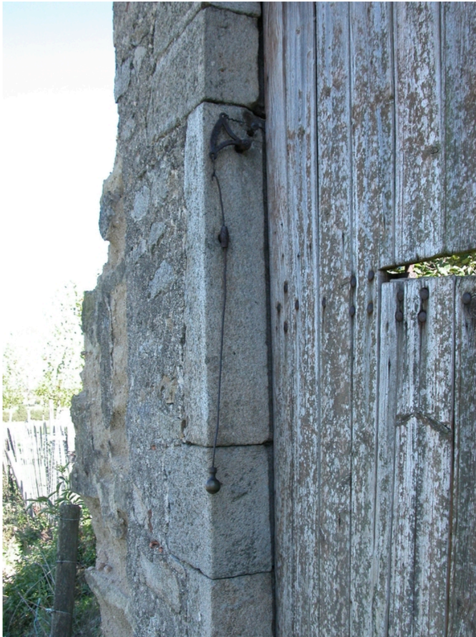
Détail du portail nord : poignée de la cloche.
