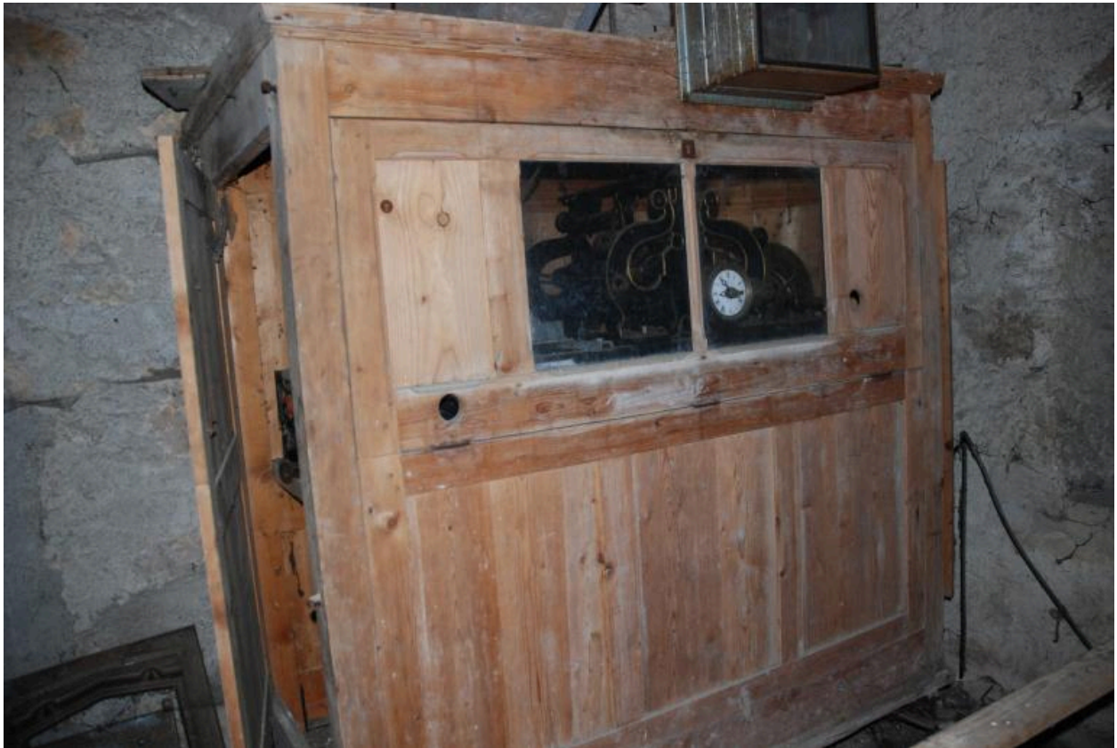
Vue d'ensemble du mécanisme de l'horloge dans son bâti
