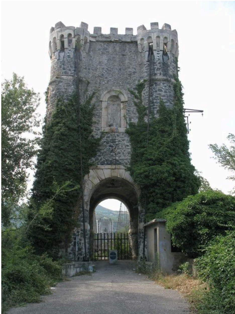
Tour formant tête de pont sur la rive gauche, face sud-est : vue rapprochée
