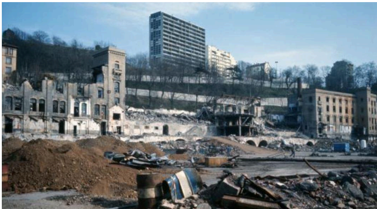
Démolition des usines Gillet 1977 (BM Lyon - CRDP de Lyon))
