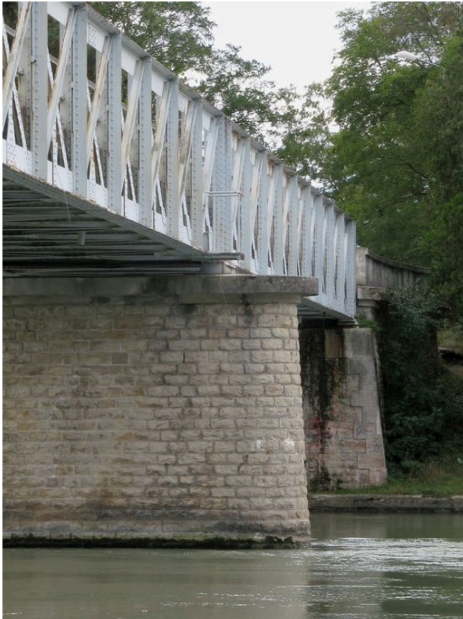
Vue partielle, tablier, pile et culée gauche, face aval (depuis la rive droite)
