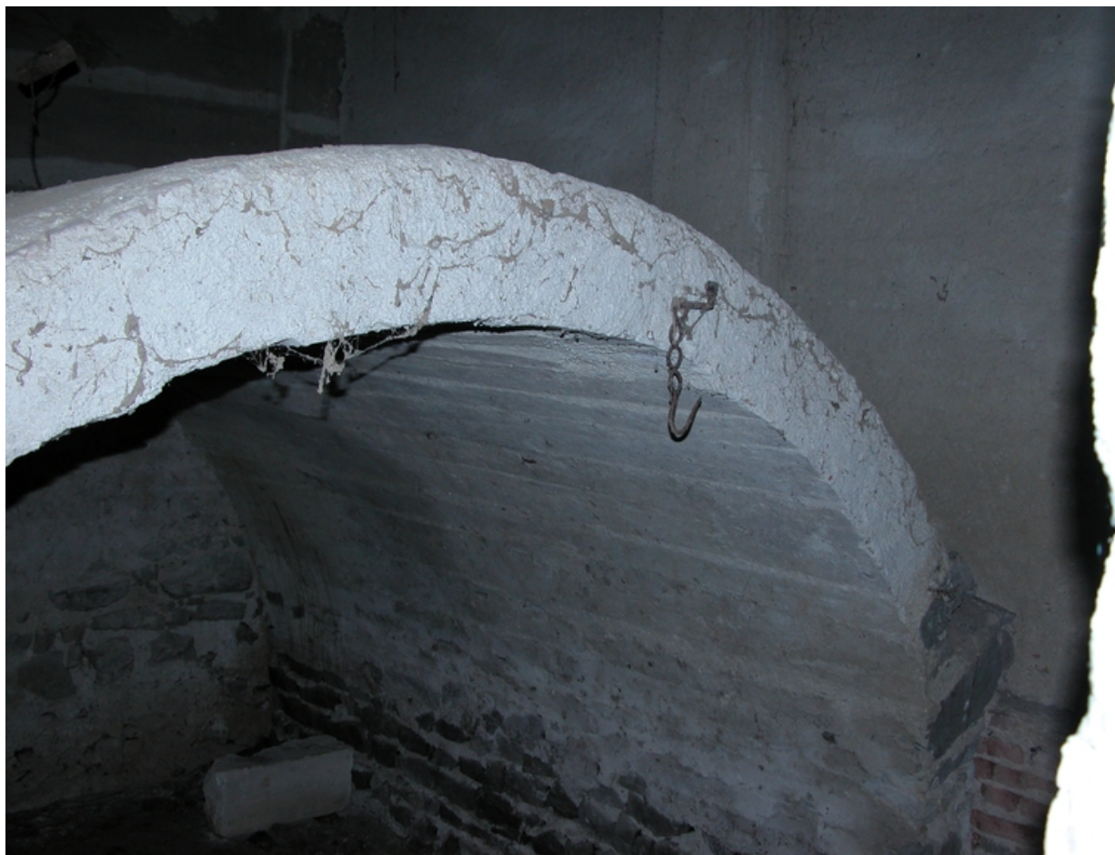
Vue intérieure du rez-de-chaussée : cellier voûté.
