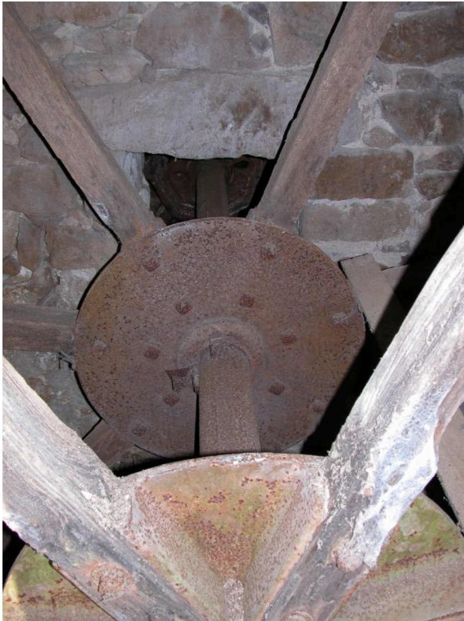
Façade ouest du moulin, détail axe de la roue à aubes.
