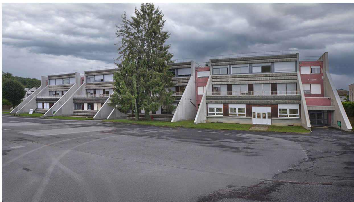
Vue d'ensemble du bâtiment d'enseignement, depuis le sud
