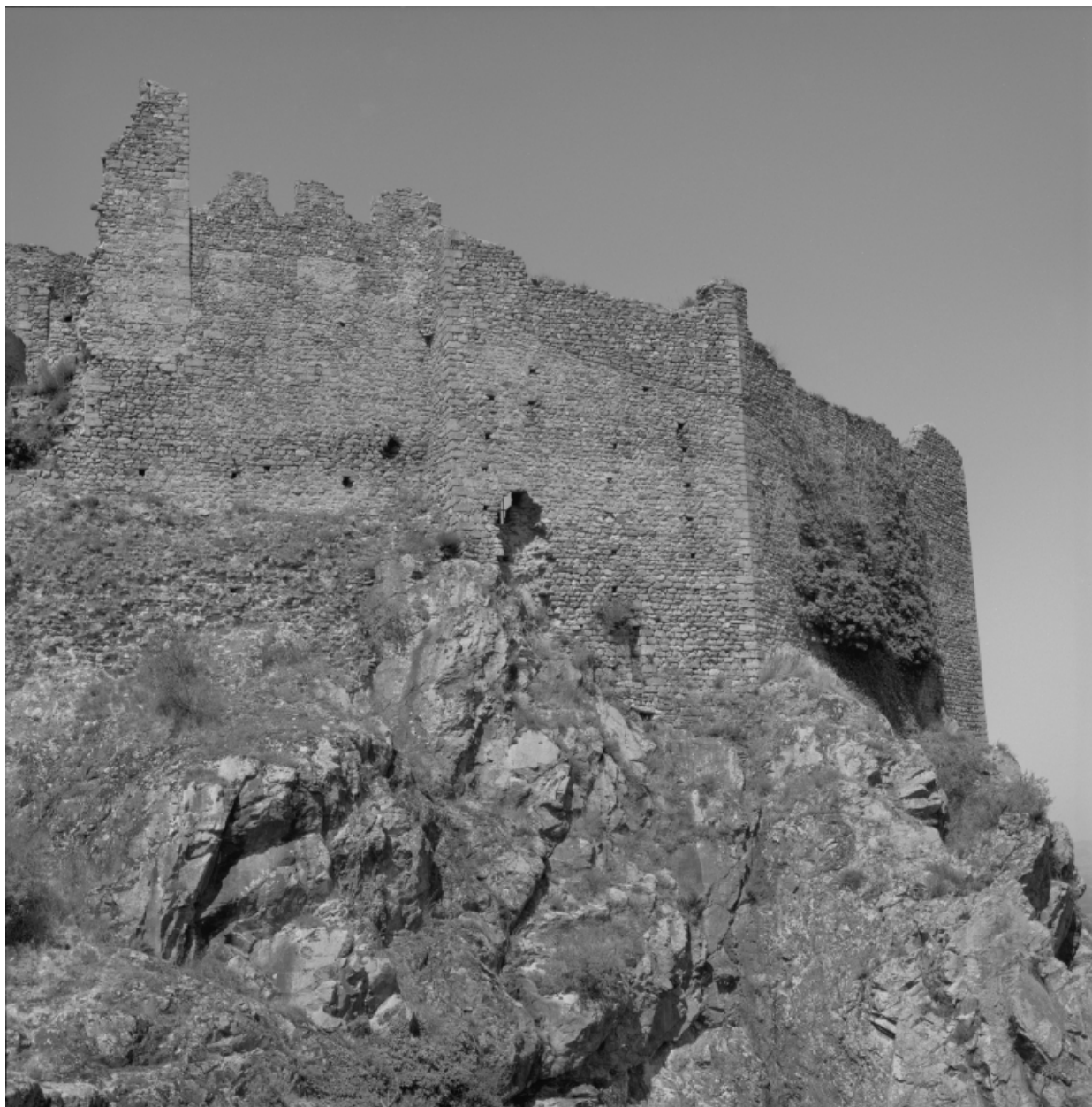
Château fort primitif : vue extérieure de la partie sud, du sud.
