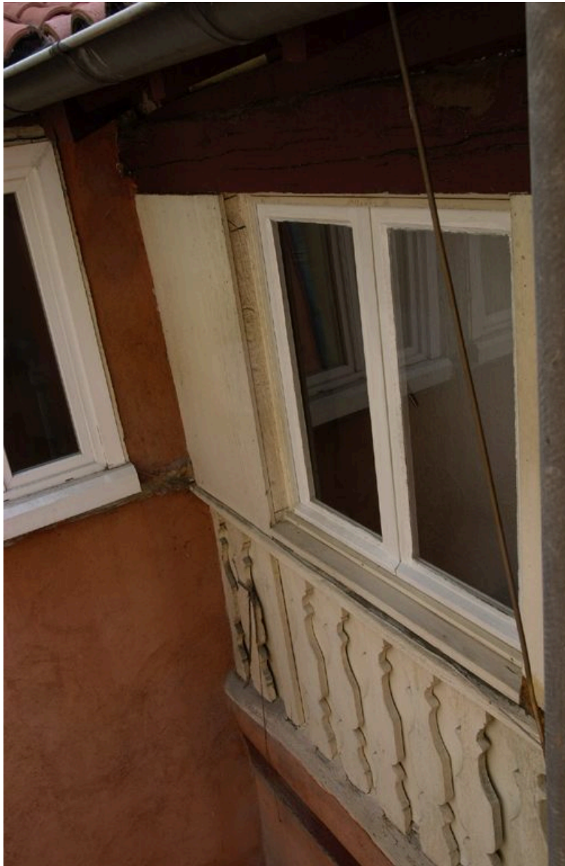
La cour : galerie, dernier étage carré
