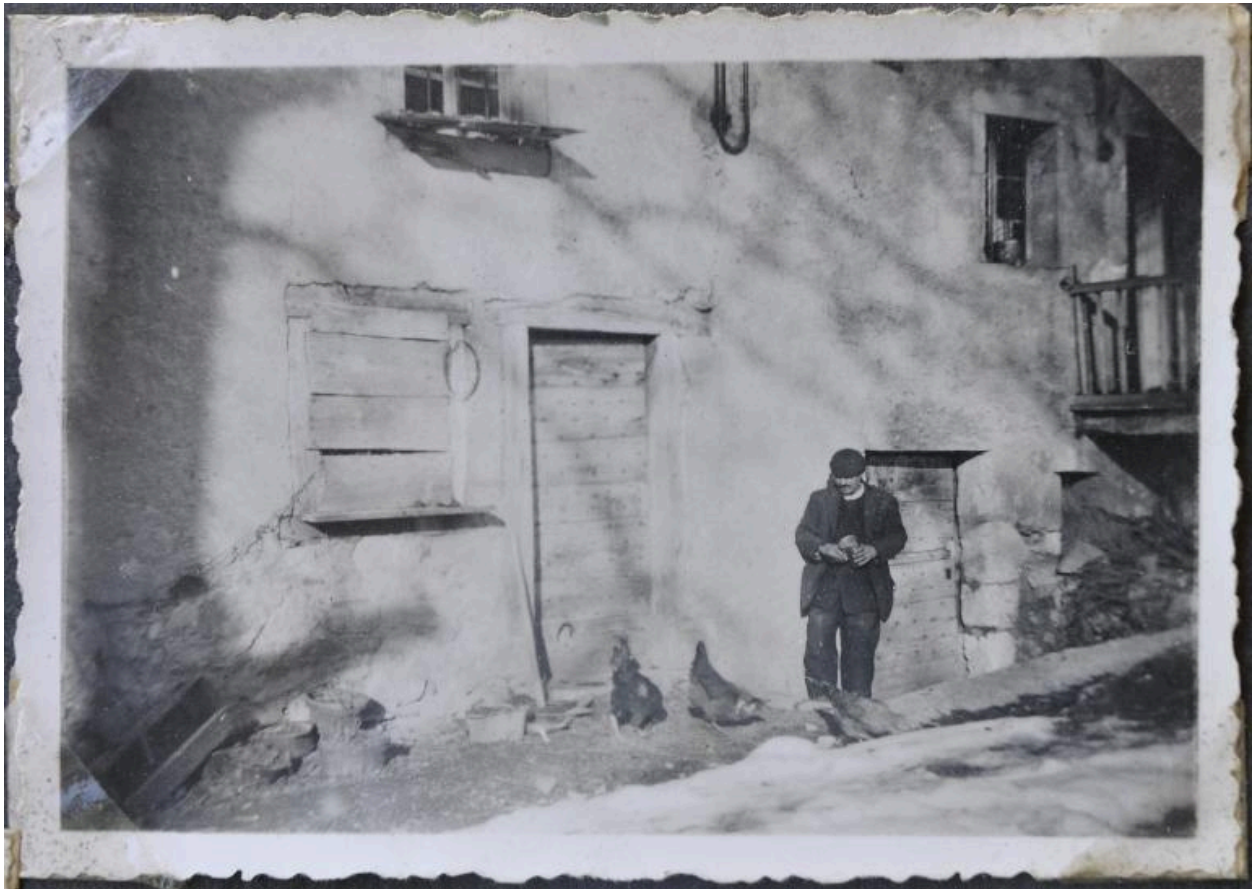
Vue de l'habitation aval. Photographie ancienne (coll. part.).
