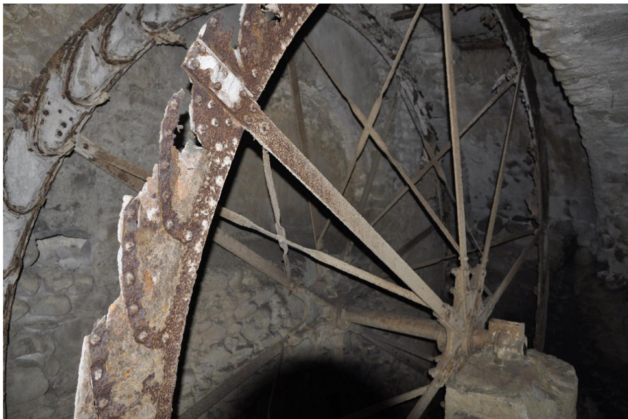
Roue de l'ancien système hydraulique (vue d'intérieur)
