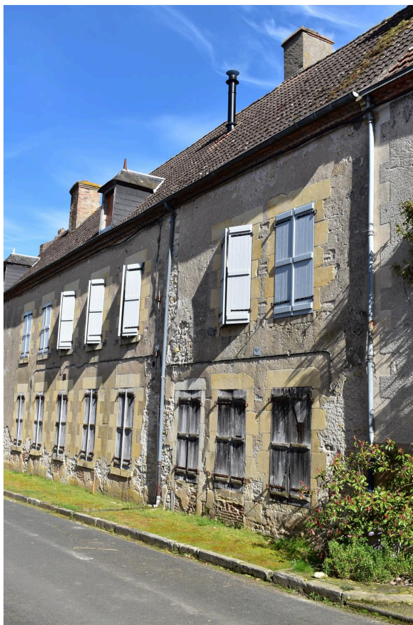
Maison, 12, rue d'Allier, parcelle cadastrale B01 : 1132. Vue générale de la façade sur rue, limite du 18e siècle et 19e siècle.
