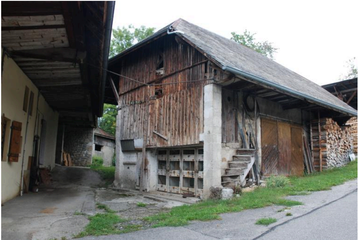
Viuz-Nord, C4 260. Fermes, actuellement maison. Vue d'ensemble de la dépendance agricole (grange-étable) située sur l'arrière du logis.
