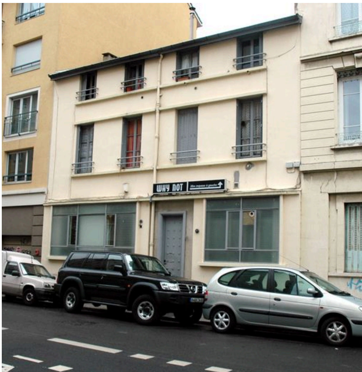
Elévation principale depuis le sud-ouest
