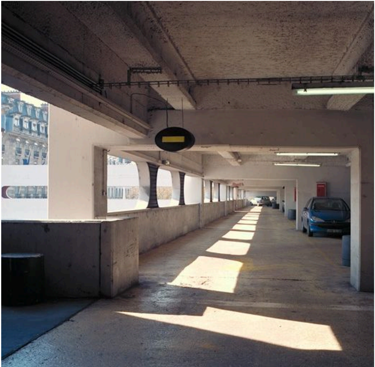
Détail des abouts de poutres ajourées constituant la structure du parking
