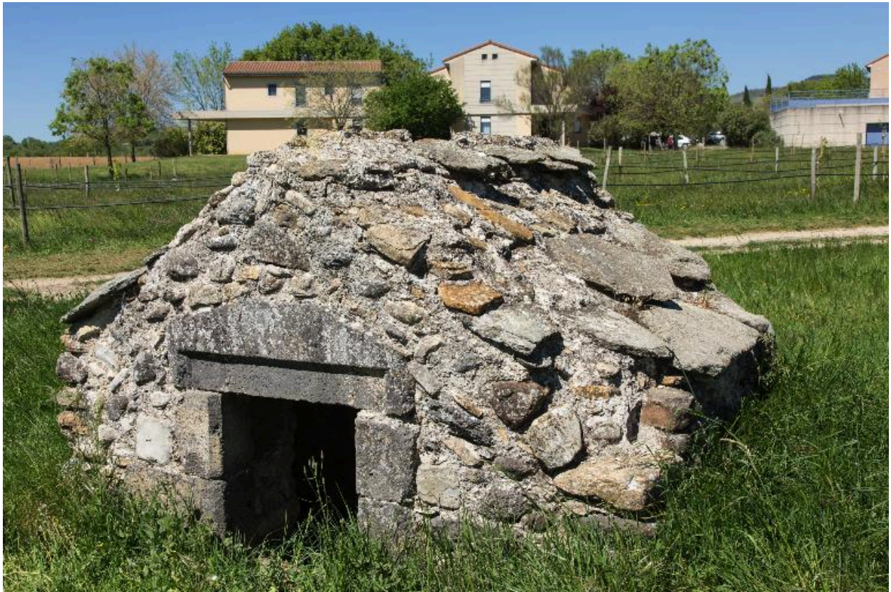
Mère des fontaines : toiture et entrée côté sud
