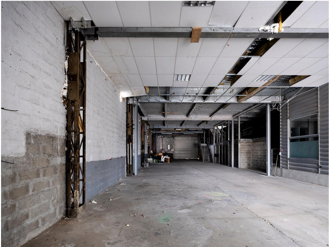
Vue intérieure avant démolition
