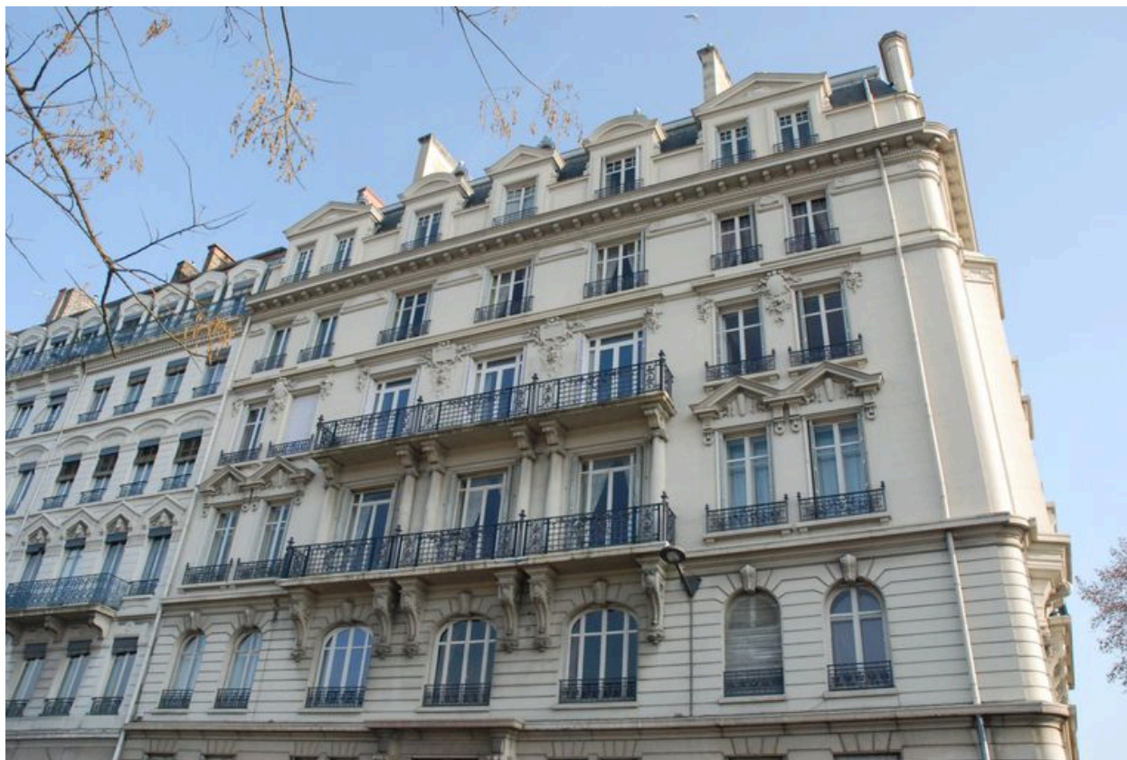
Vue de l'élévation sur quai
