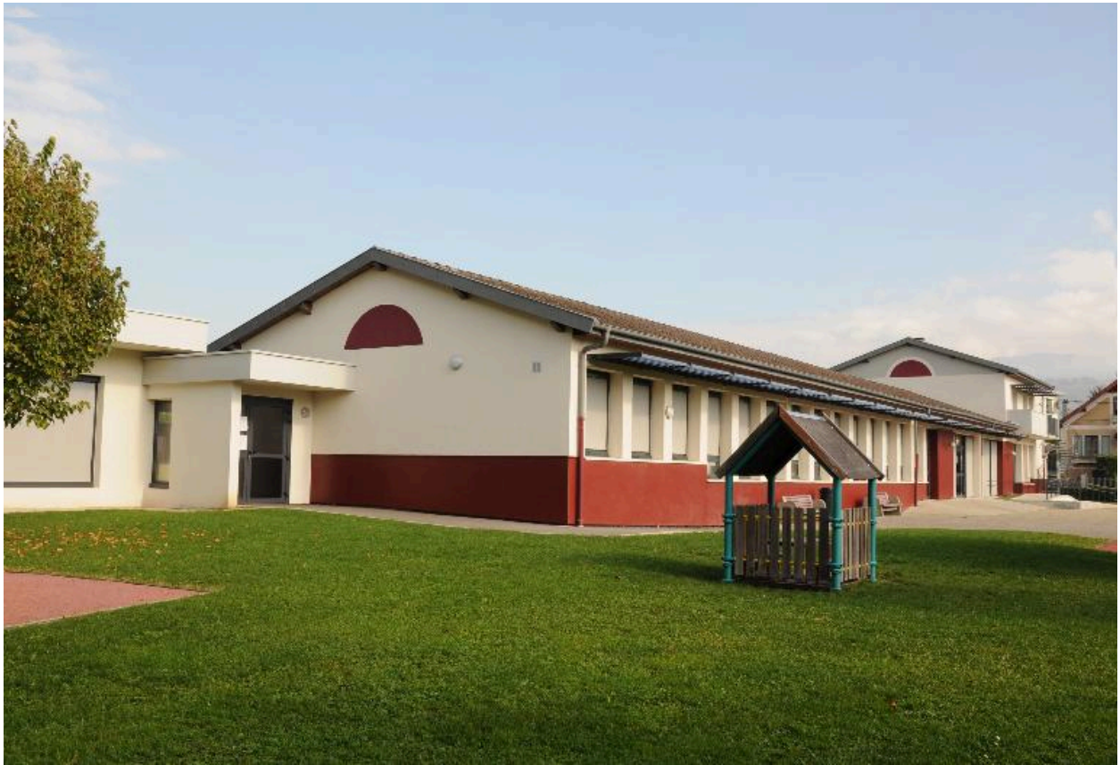
Vue de trois-quarts gauche depuis la cour
