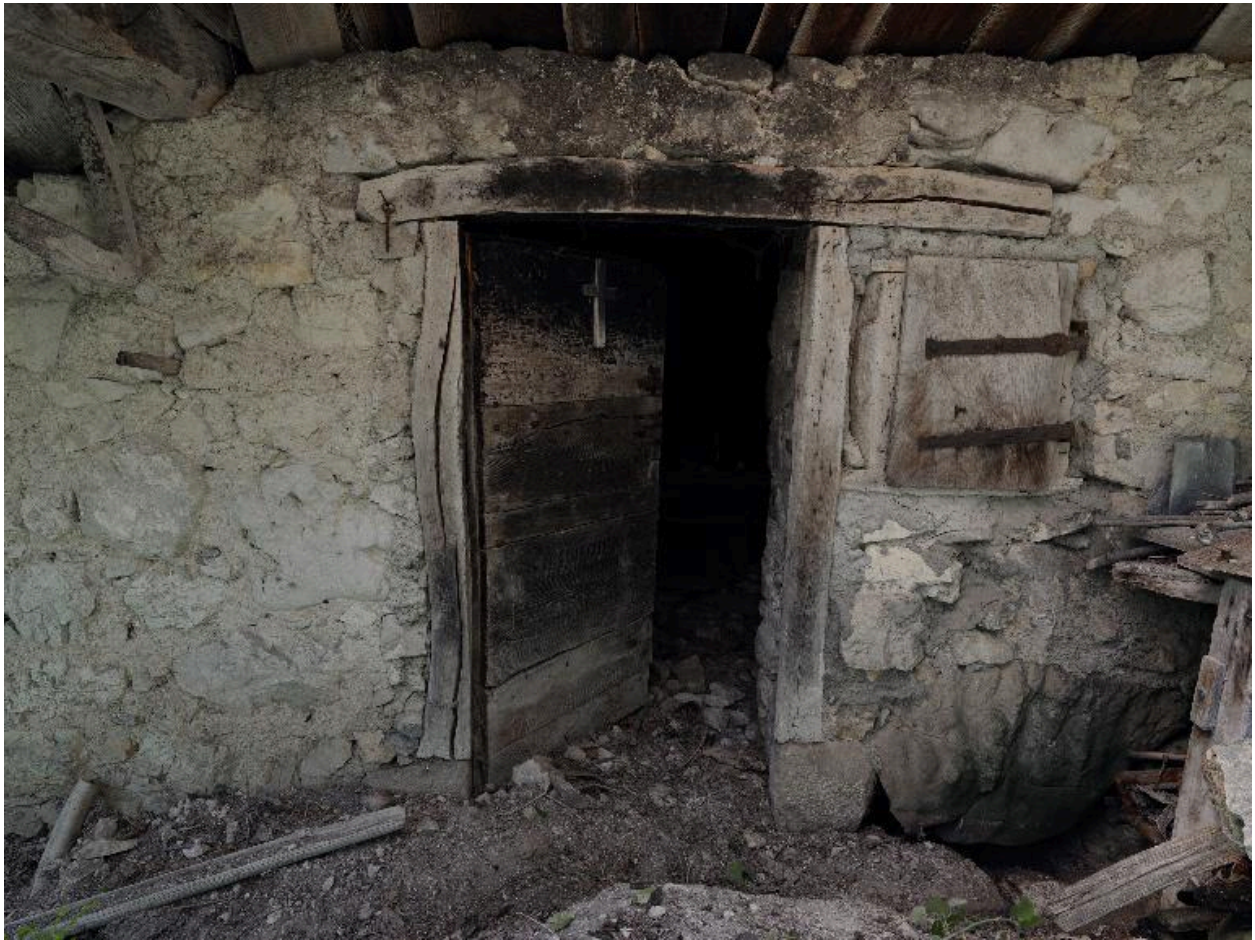
Détail de la façade de la travée d'habitation ; en haut à gauche, crochet en bois fixé sous l'avant-toit.
