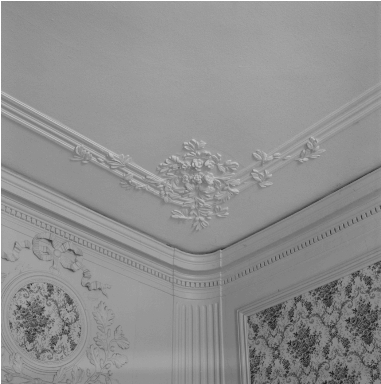
Détail du décor du plafond et des murs.
