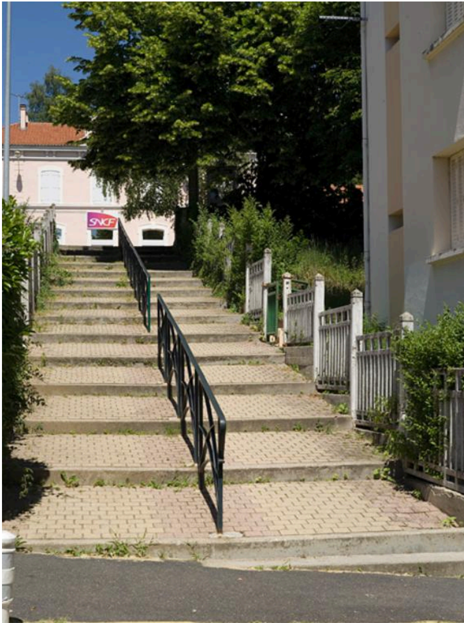
Escalier extérieur reliant la partie haute et la partie basse de l'avenue.
