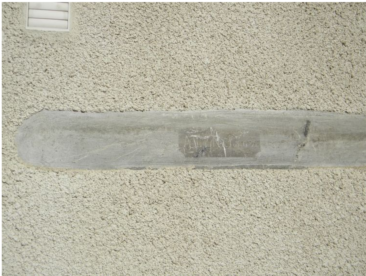
Ancien linteau de porte portant l'inscription AL.N. 1867 (A3 2441)
