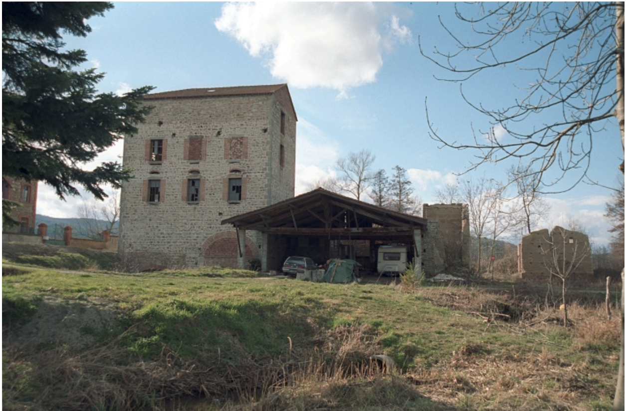
Vue d'ensemble depuis l'est du moulin et de la scierie.
