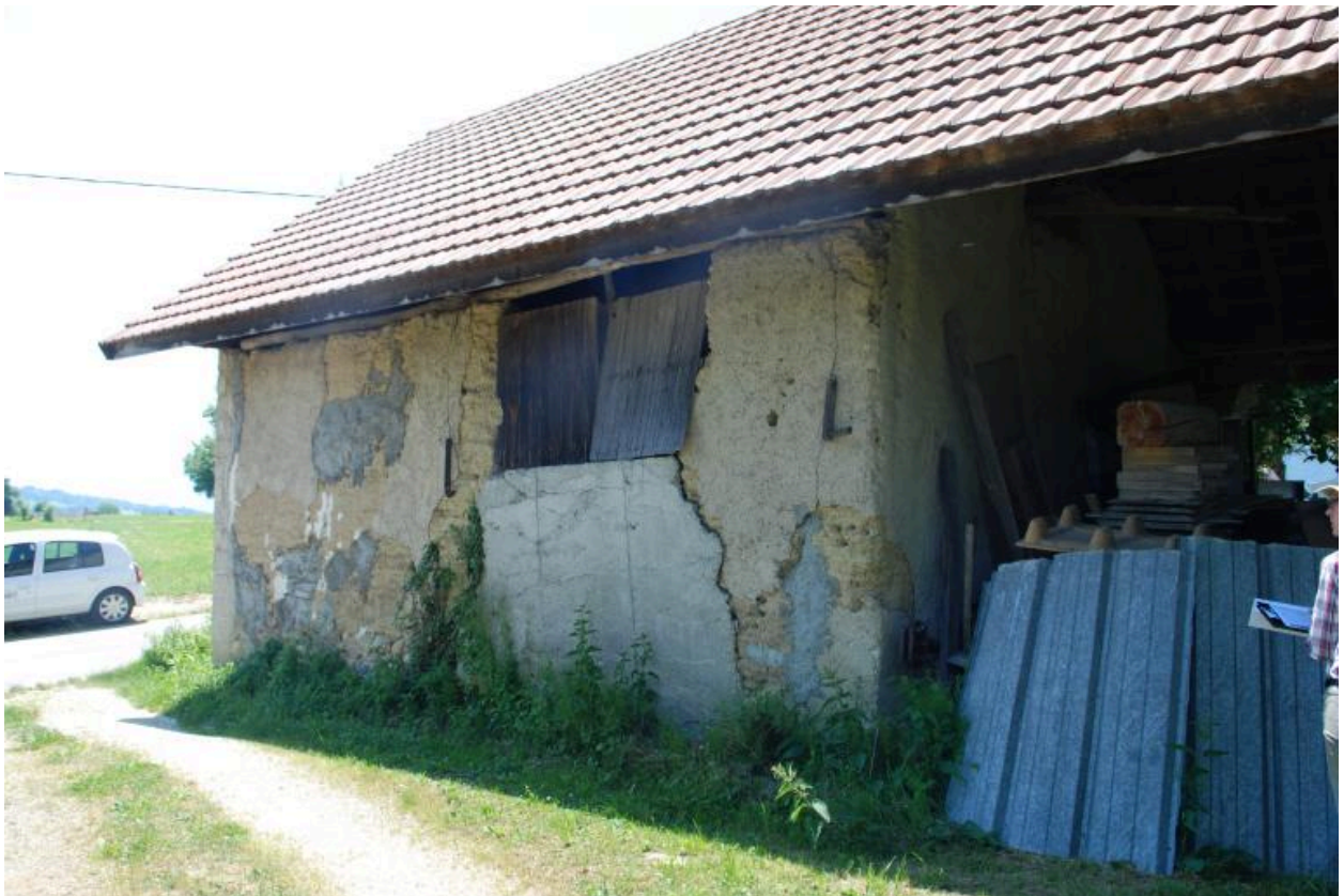
Vue arrière de la dépendance.
