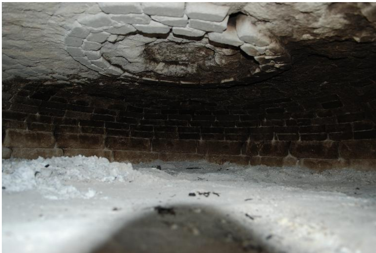
vue intérieure de la voûte du four.
