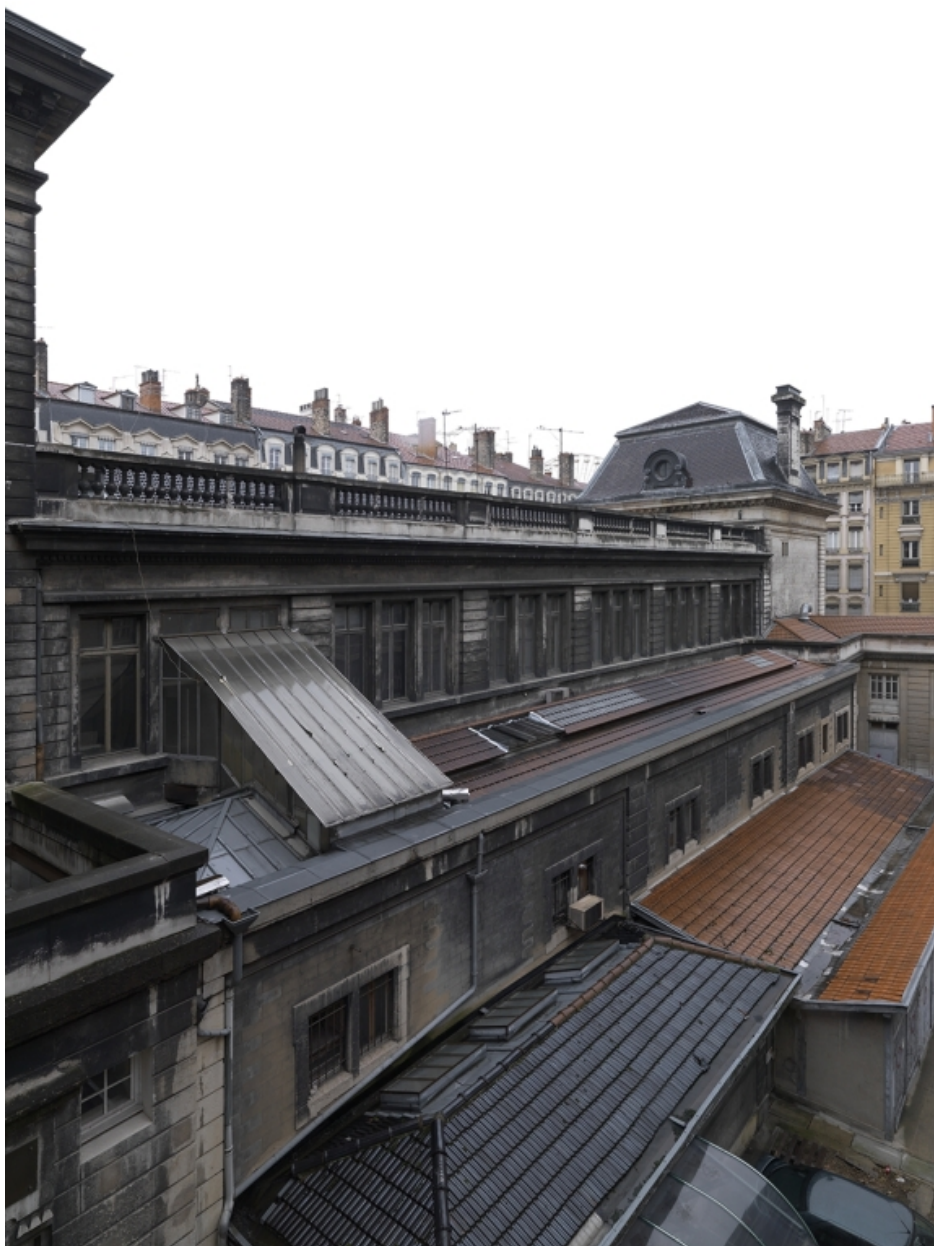
Bâtiment A'. Façade nord sur la cour du Midi, et les garages accolés à la façade
