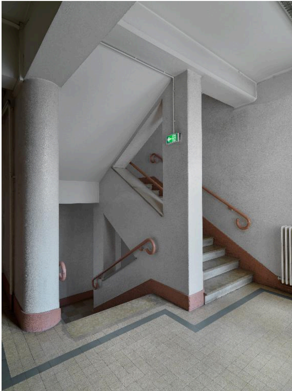
Escalier sud, palier du 1er étage
