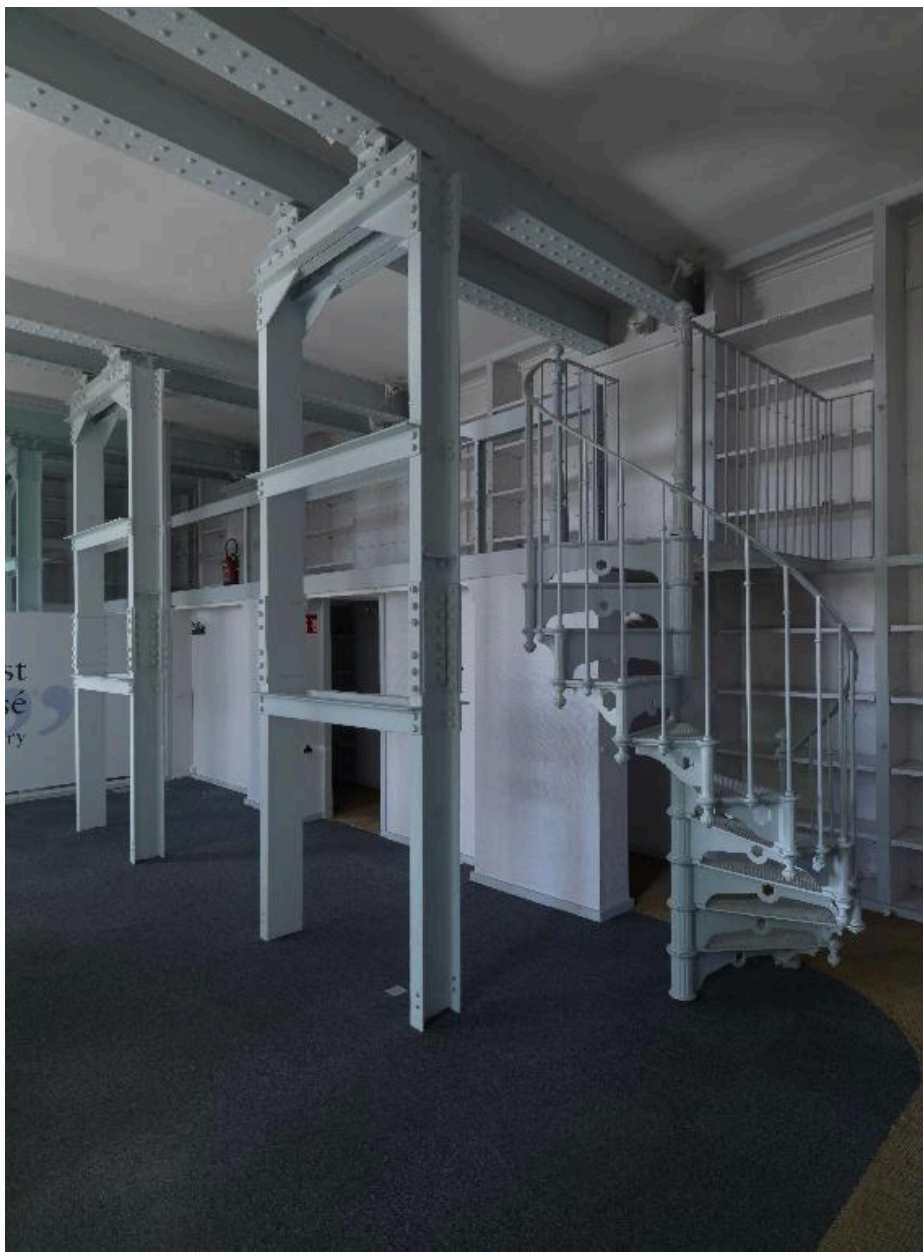
Vue intérieure de l'ancien réfectoire, avec les chevalements métalliques installés en 1937
