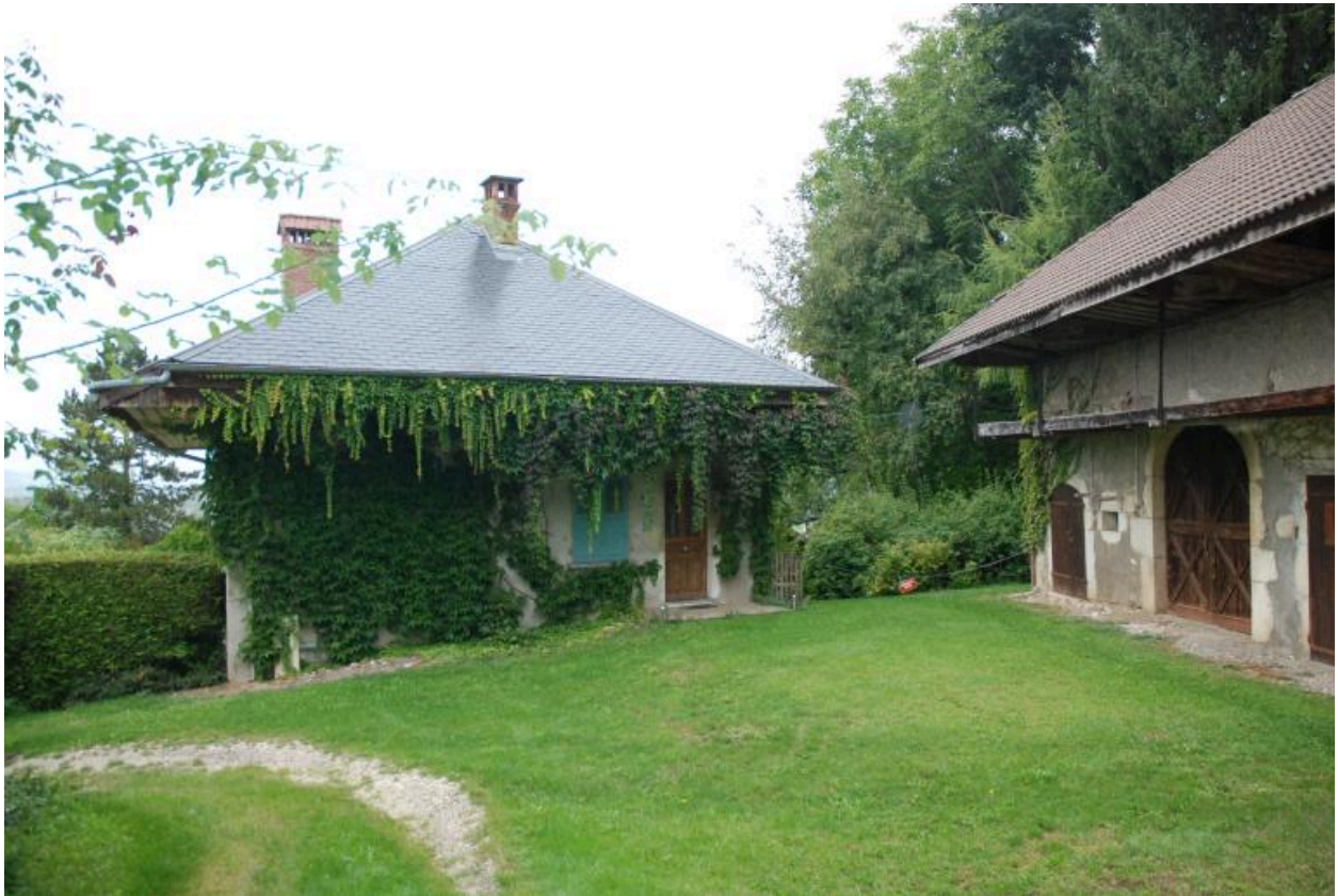
Vue d'ensemble du mur pignon est du corps de bâtiment du logis.
