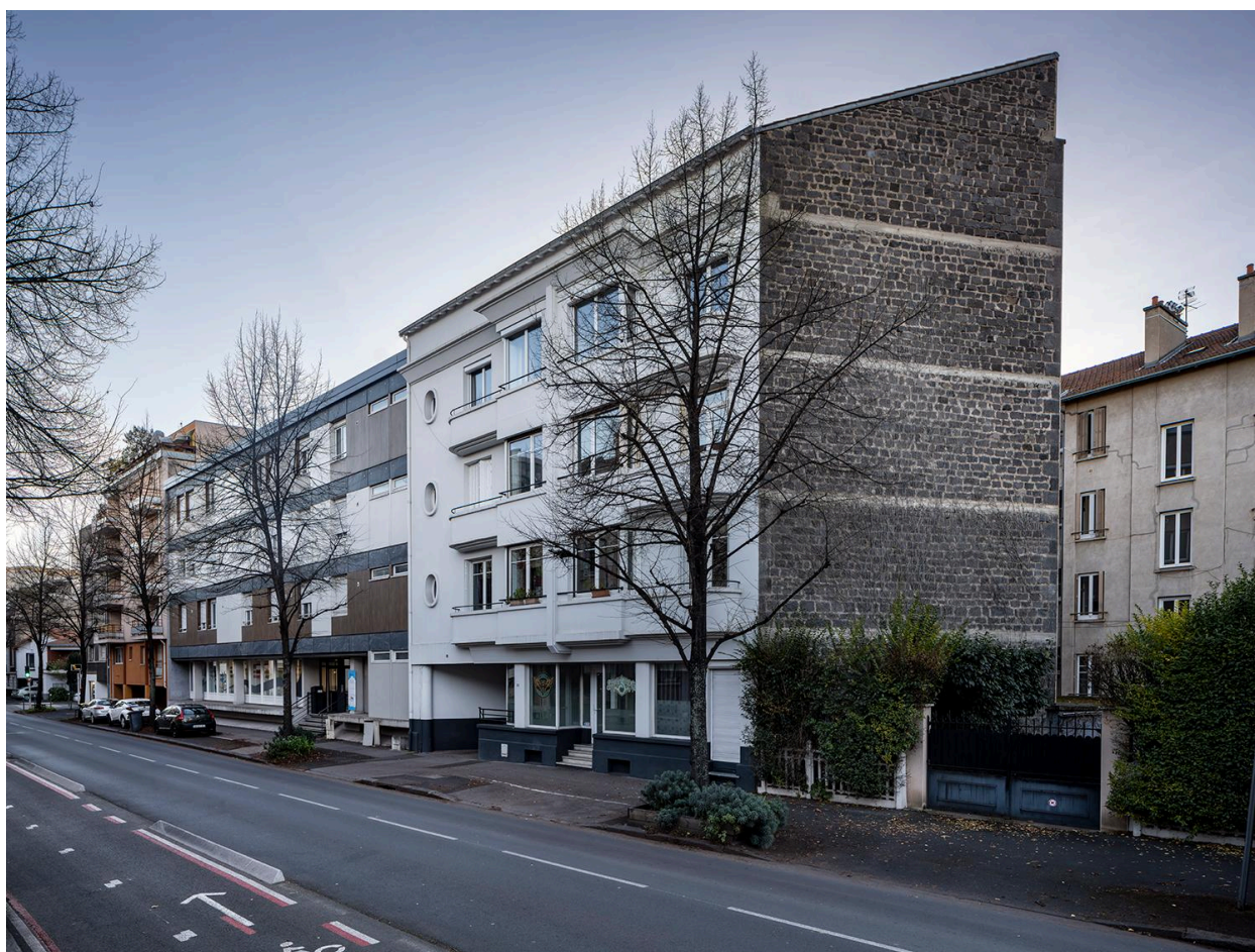
Elévation latérale aveugle et façade sur le boulevard Aristide-Briand
