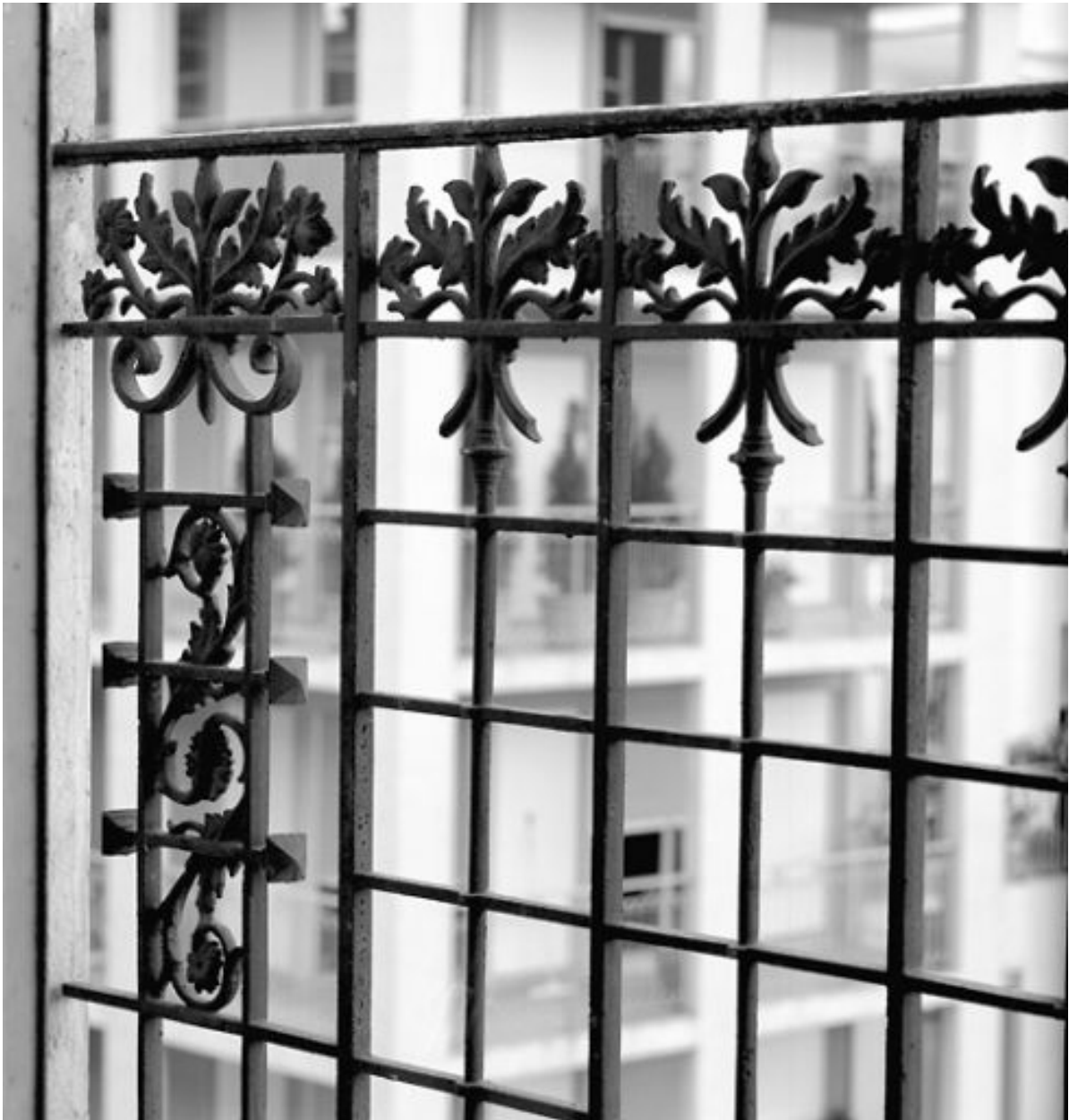
Détail du garde-corps d'un balcon d'appartement, 32 rue Quivogne
