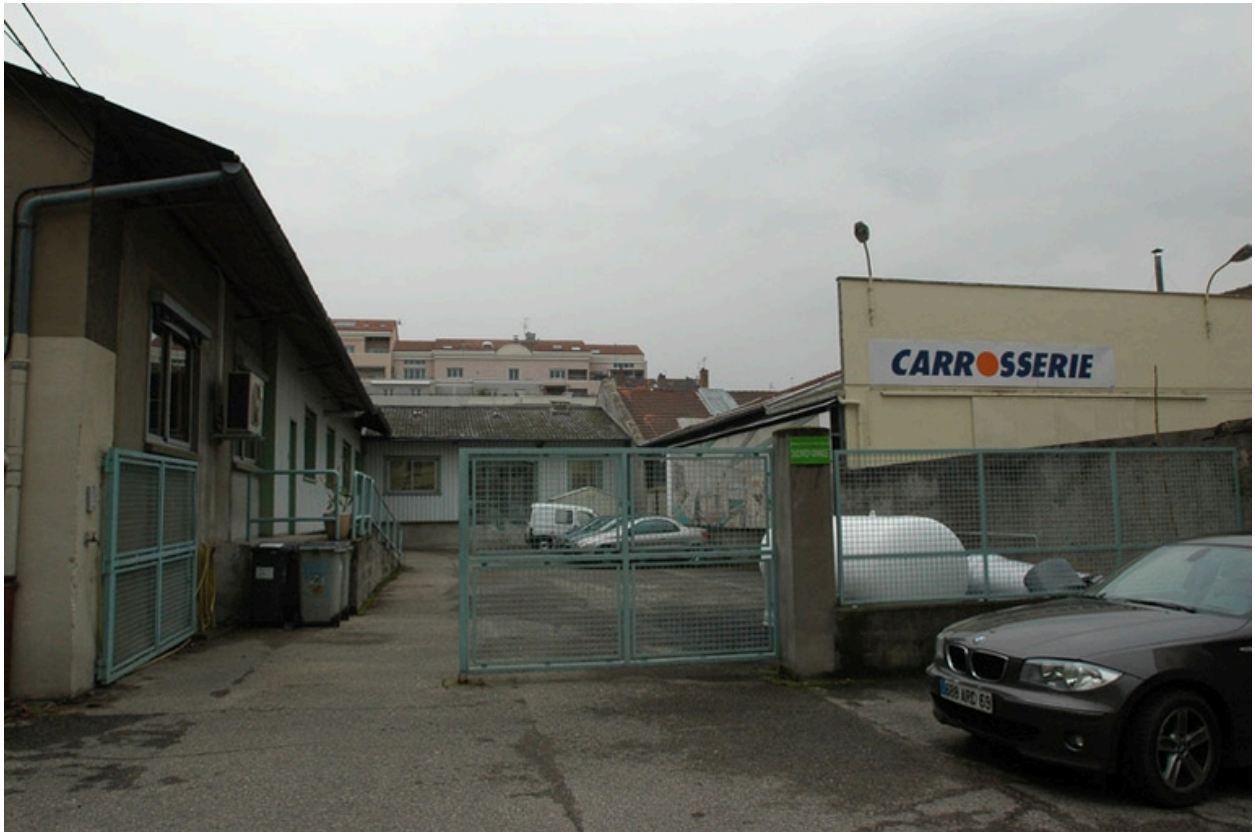
Ateliers sur cour, vue ouest.
