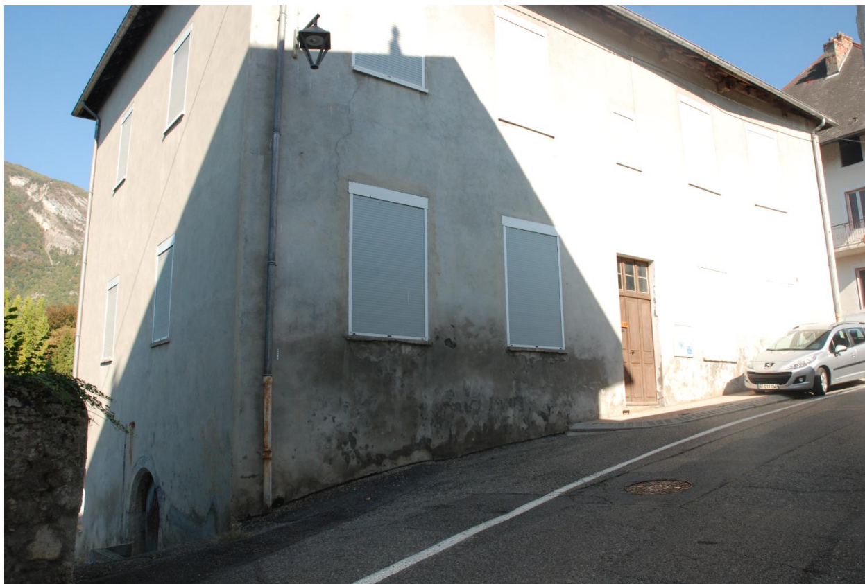
Ancienne école de filles (2018 E1 215), vue depuis le sud-est.
