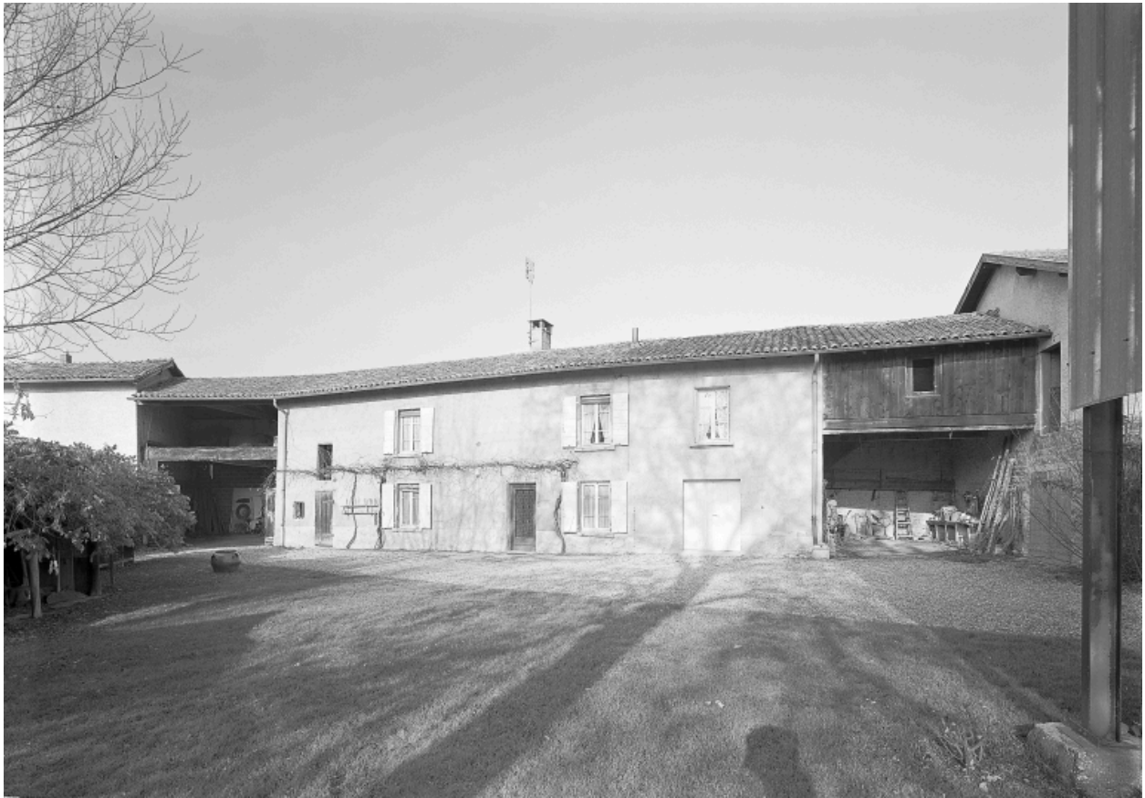
Vue d'ensemble élévation sur cour.
