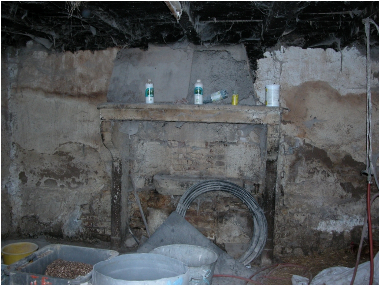
Vue intérieure du fournil.
