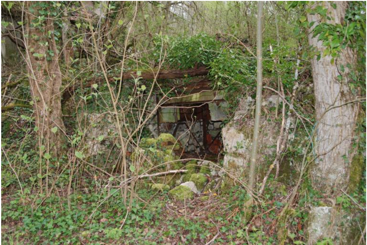
D7 478, Pételaz-Est, remise. Vue d'ensemble.
