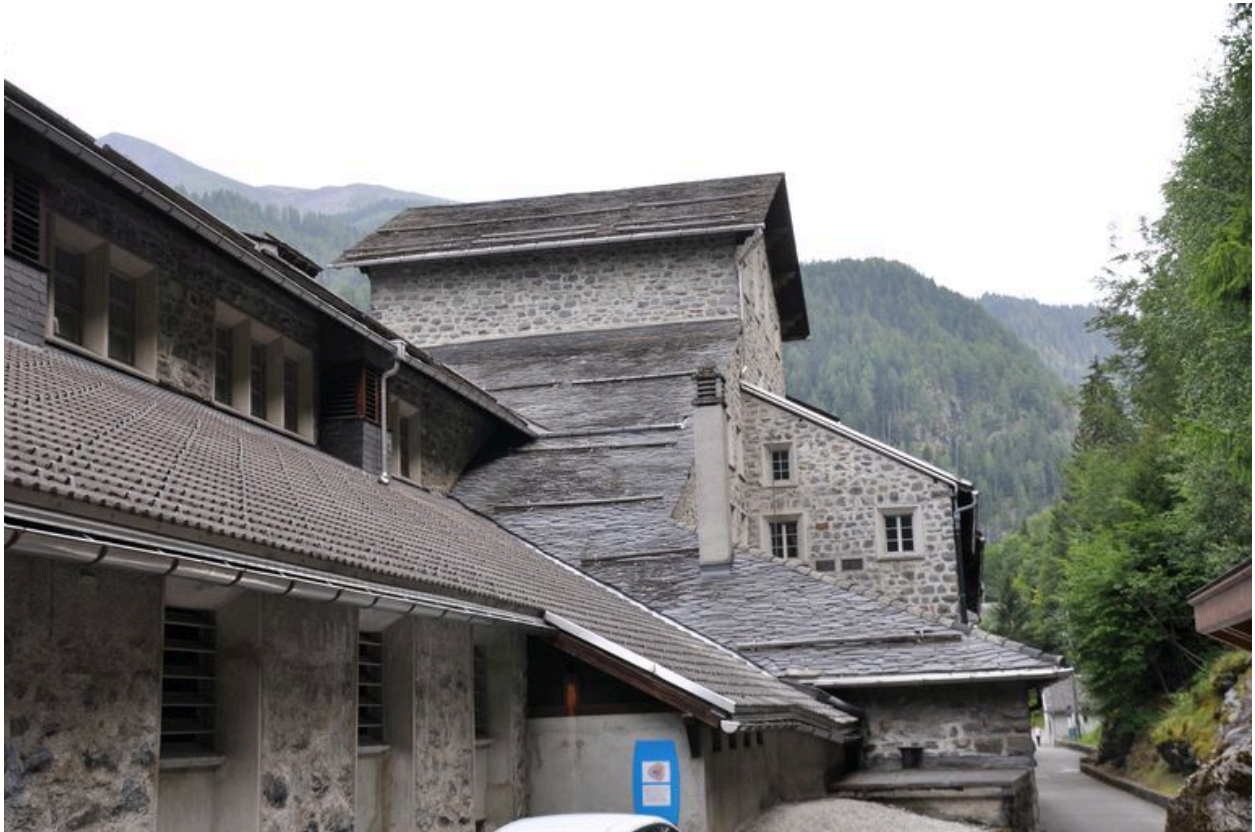
Façade postérieur de l'usine CFF du Châtelard
