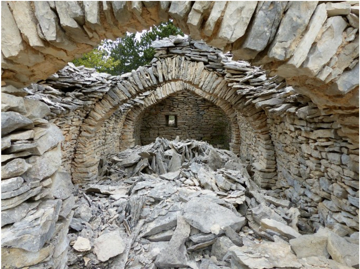
Vue de volume prise du sud.
