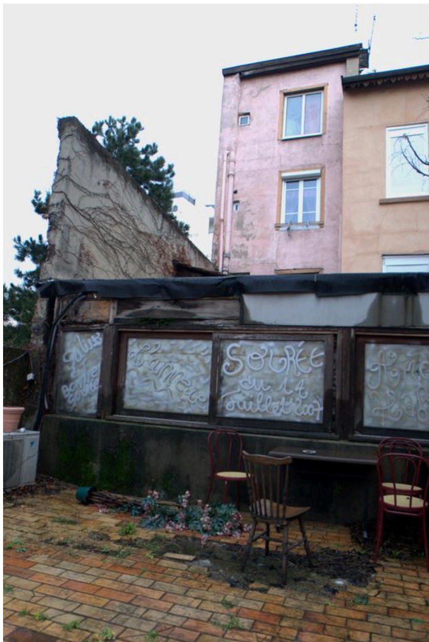
Elévation postérieure depuis le sud-est
