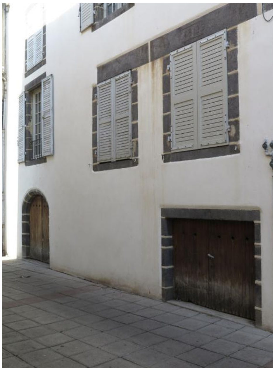
Vue partielle de la façade : accès au chai (en sous-sol)
